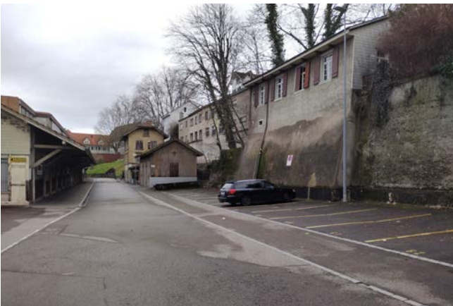
Gebäude unterer Graben 2.
