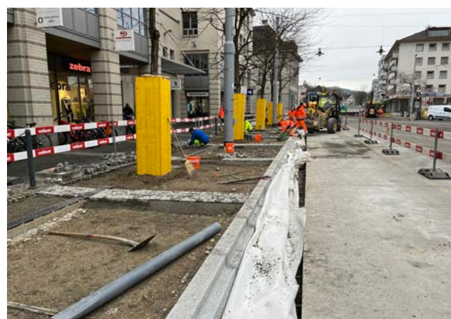
Pflästerungsarbeiten beim Bahnhofplatz.
