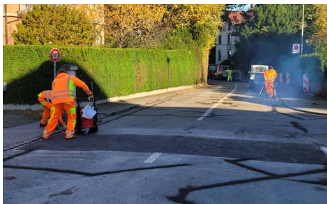
Rissanierungsarbeiten mit Heissbitumen an der Ringstrasse.
