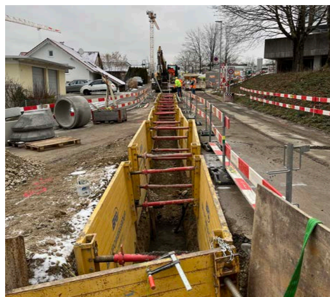
Entwässerungsarbeiten an der Pfaffenholzstrasse.
