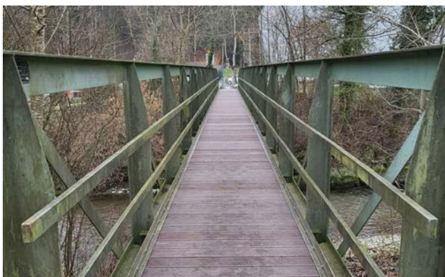
Neuer Belag auf der Brücke Walzmühle.
