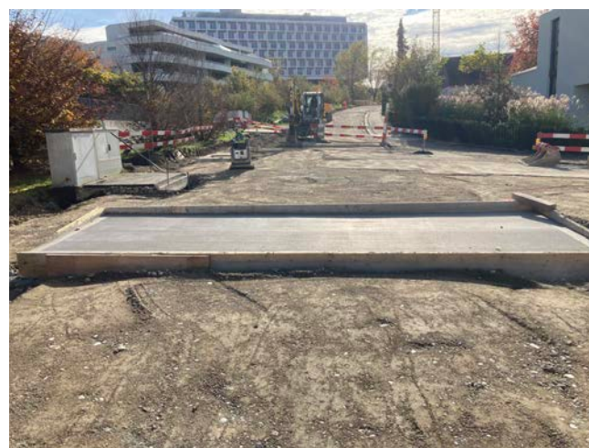
Betonrampe an der Pfaffenholzstrasse.
