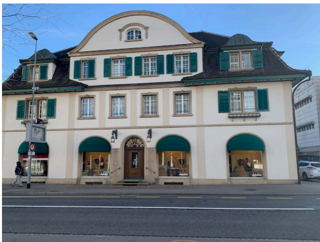
Die sanierte Hausfassade an der Bahnhofstrasse 56.
