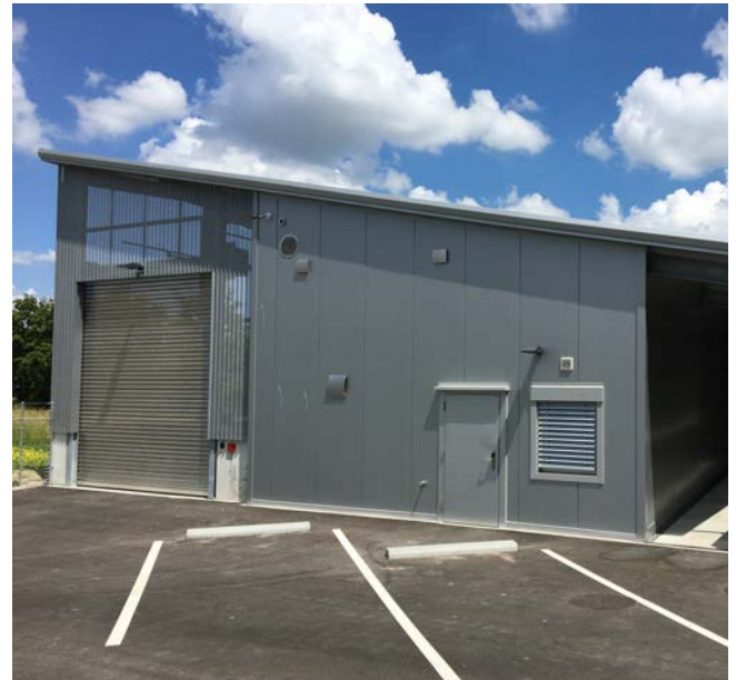
Das Gebäude der neuen Tierkörpersammelstelle.
