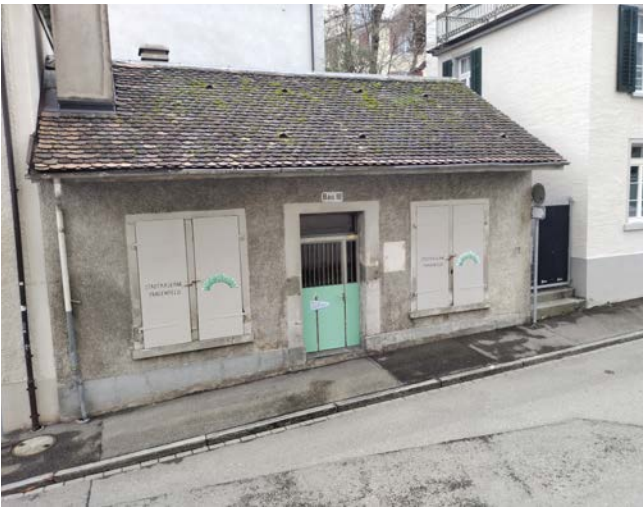
Gebäude unterer Graben 1.
