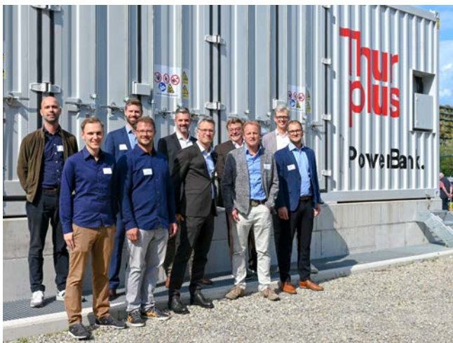
Im August 2023 nahm Thurplus das 3-MW-Batteriespeichersystem in Betrieb.
